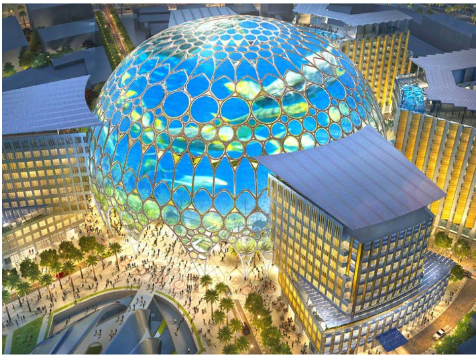
Herzstück im Zentrum des EXPO-Geländes: die Al Wasl Plaza
